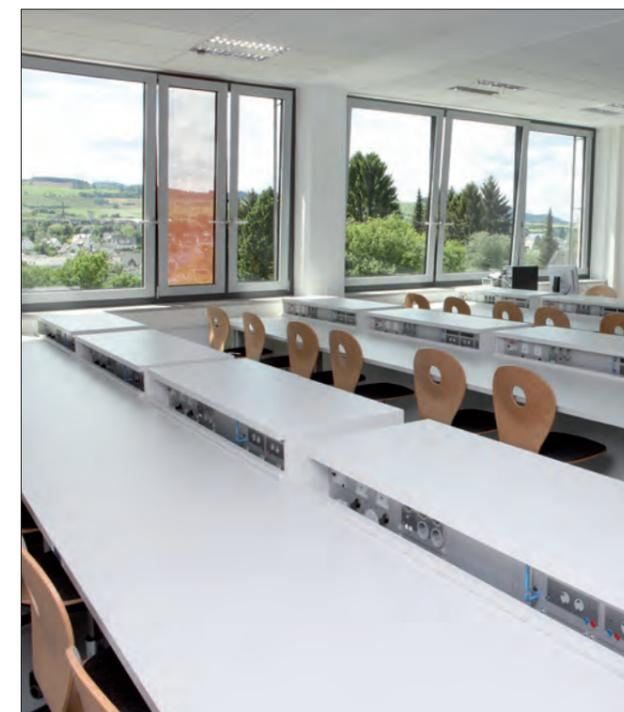
Versenkaufbauten zur Hälfte eingefahren.
