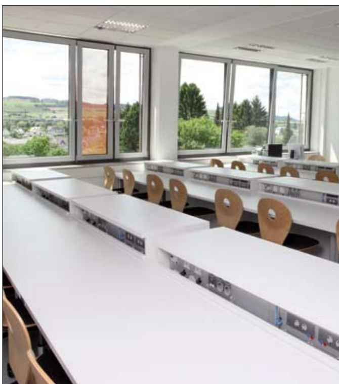
Versenkaufbauten zur Hälfte eingefahren.
