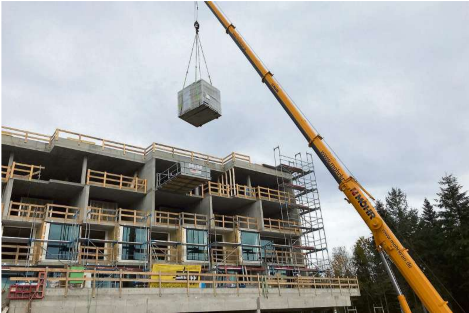
Ein Badezimmer fliegt durch die Luft. Vor der Rohbau-Fassade des Hotels „Fritz“ hängt die Komplettlösung noch in der Luft. Bilder: Hannes Kuhnert
